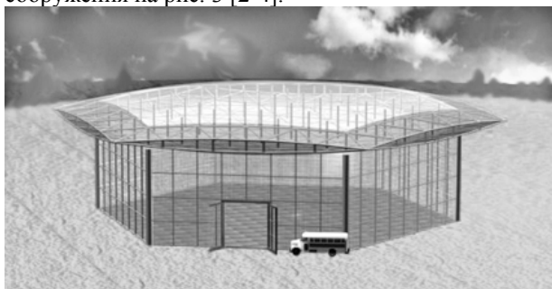
Рисунок 1 - Быстровозводимое мембранно-стержневое сооружение шестиугольного очертания пролетом 60 метров
